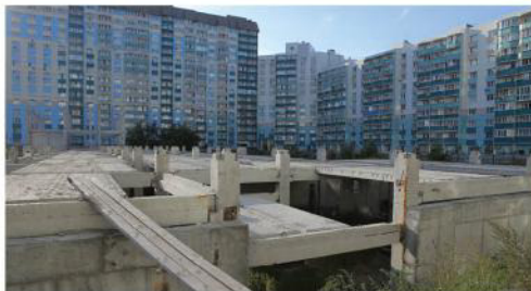
У будущей школы в Горском микрорайоне уже завершен нулевой цикл
