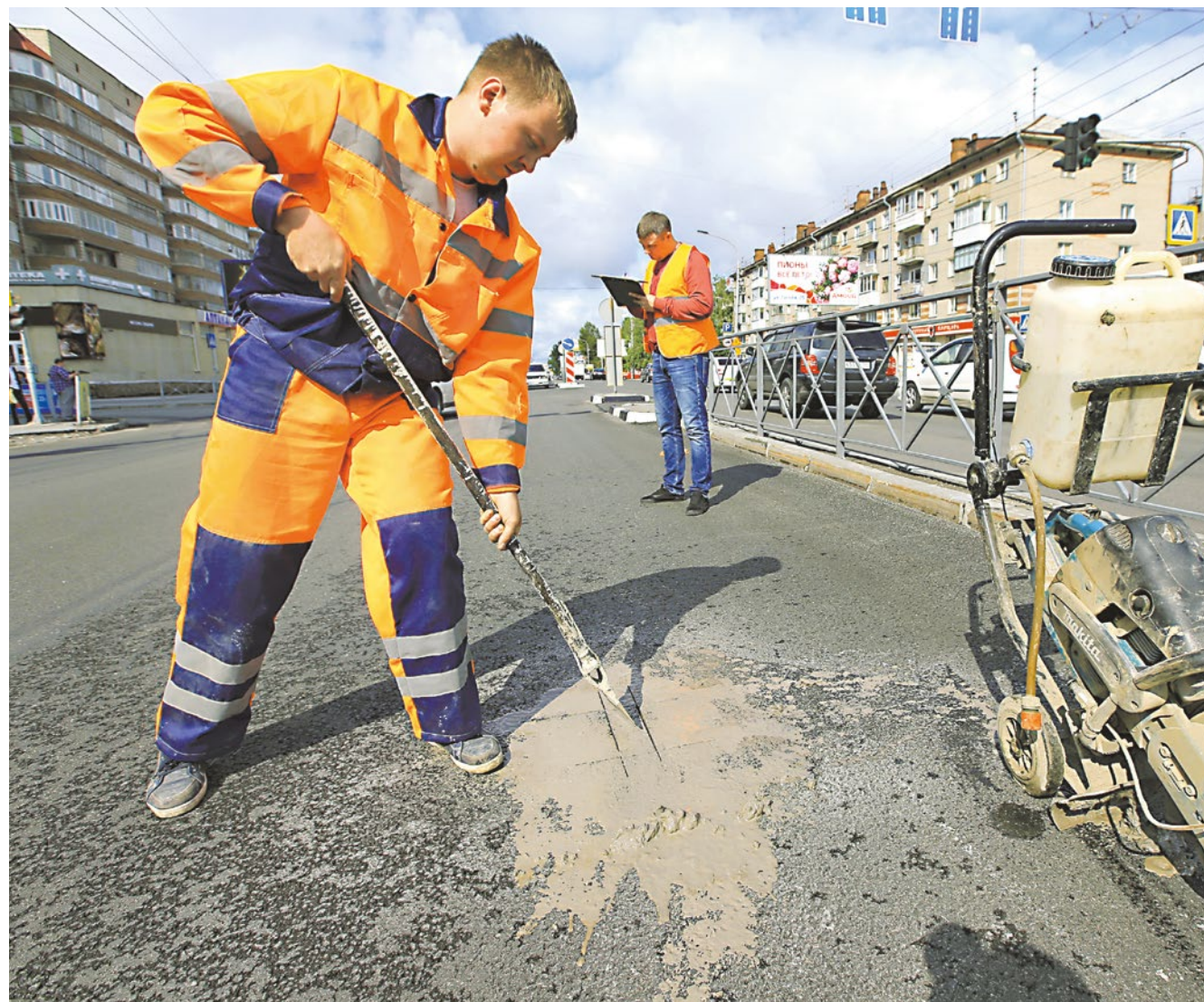
Улицу Гоголя после ремонта проверяют специалисты «Управления дорожного строительства» Новосибирска. Бензорезом выпиливают кусок асфальтового слоя — до подушки из щебня. В лаборатории проводят химические анализы асфальтобетонной смеси — соответствует ли содержание смол и других компонентов покрытия всем ГОСТам
