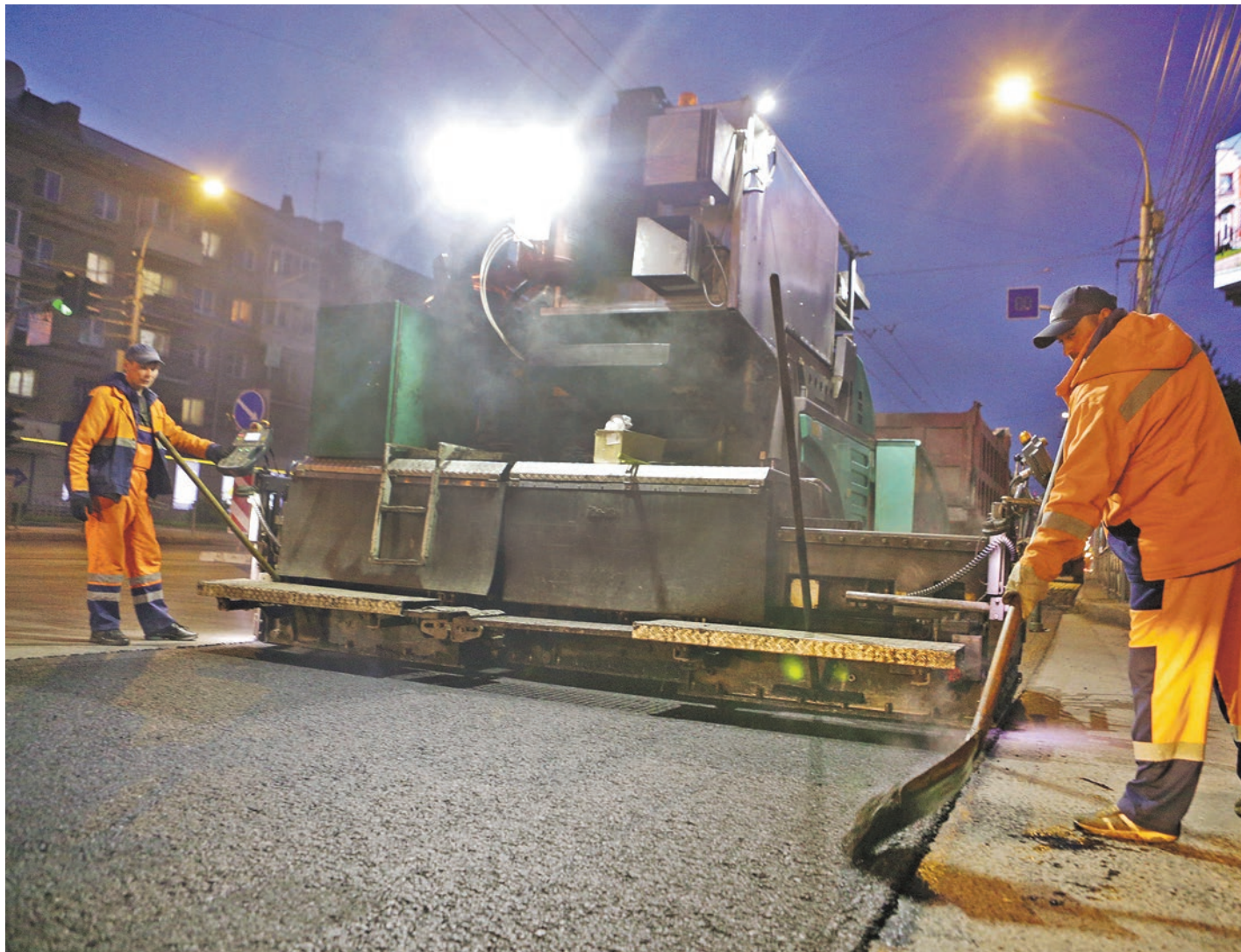
Рабочие ремонтируют участок ул. Гоголя — от ул. Семьи Шамшиных до ул. Ипподромская. Старый слой разбитого асфальта снимают и меняют на выравнивающий слой асфальтобетона
