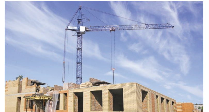
На этой площадке был заброшенный дом, его снесли и теперь на улице Чехова строят детский сад. Новое здание примет семь групп — четыре для самых маленьких — и будет оборудовано спортивным и музыкальными залами
