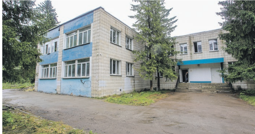
Отремонтированное здание детского сада на улице Макаренко примет детей к новому году
