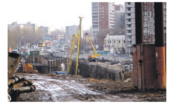
Сбойка тоннеля на месте станции «Берёзовая роща»
