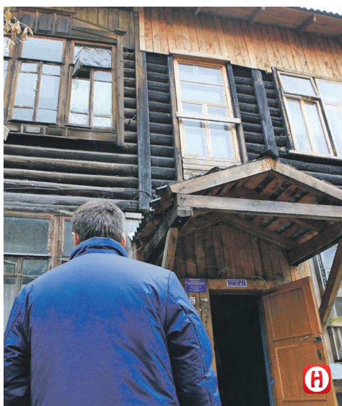
Сегодня в Новосибирске 1500 ветхих домов, которые необходимо расселить
