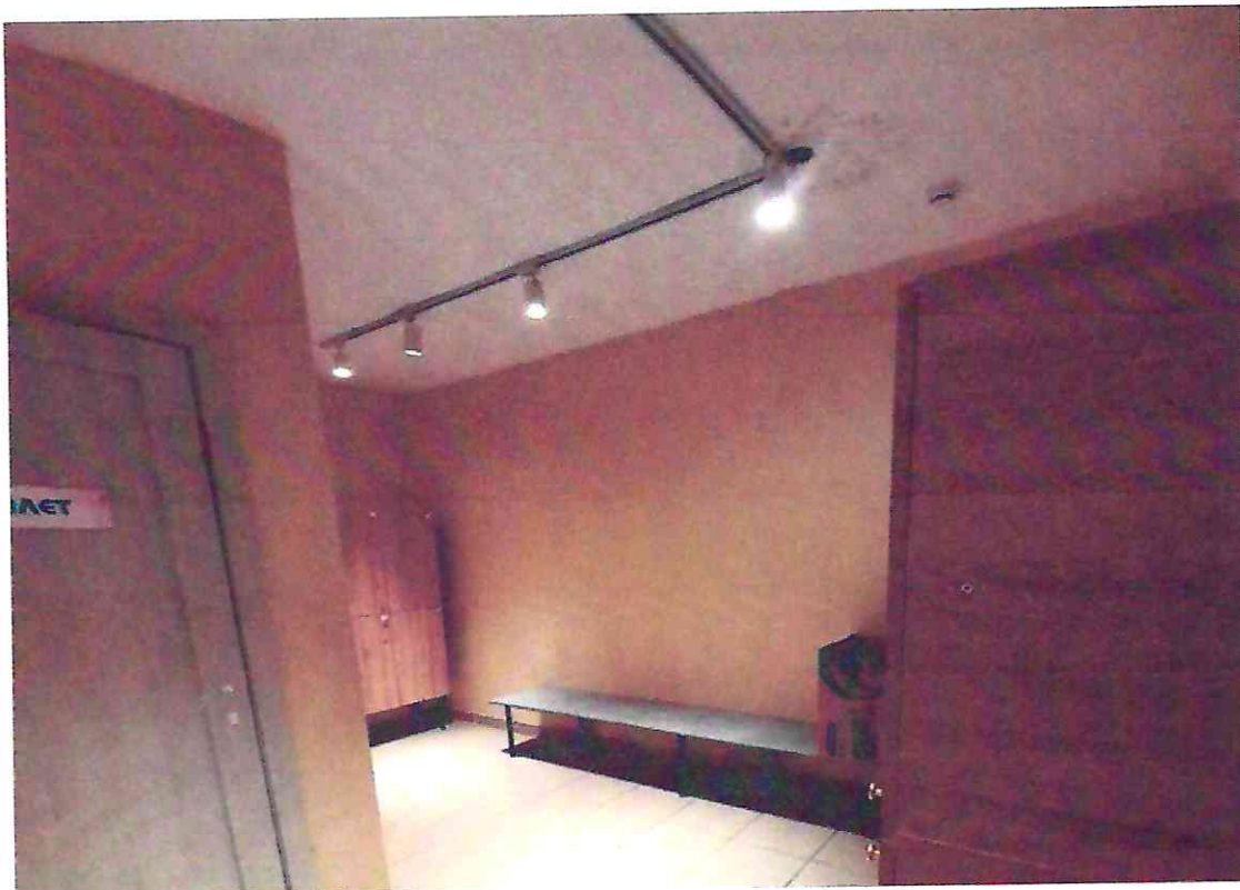
Фото № 33: Образование желтых пятен от протечки на потолке в раздевалке.
