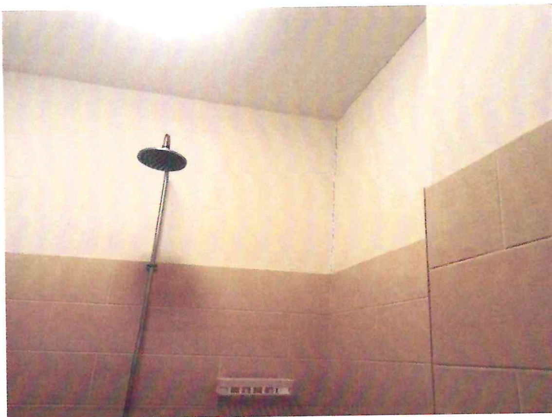
Фото № 34: Трещина на стене в душевой.
