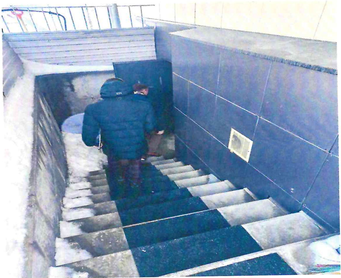
Фото № 59: Вход в подвал.
