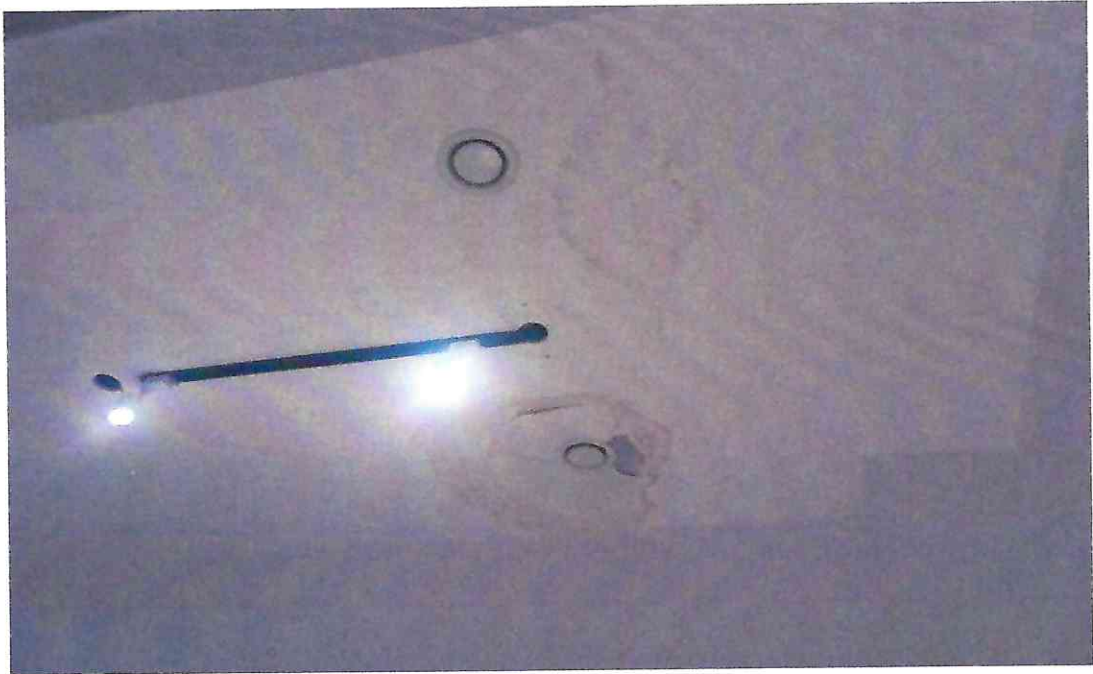
Фото № 47: Образование желтых пятен от протечки на потолке в женской раздевалке.
