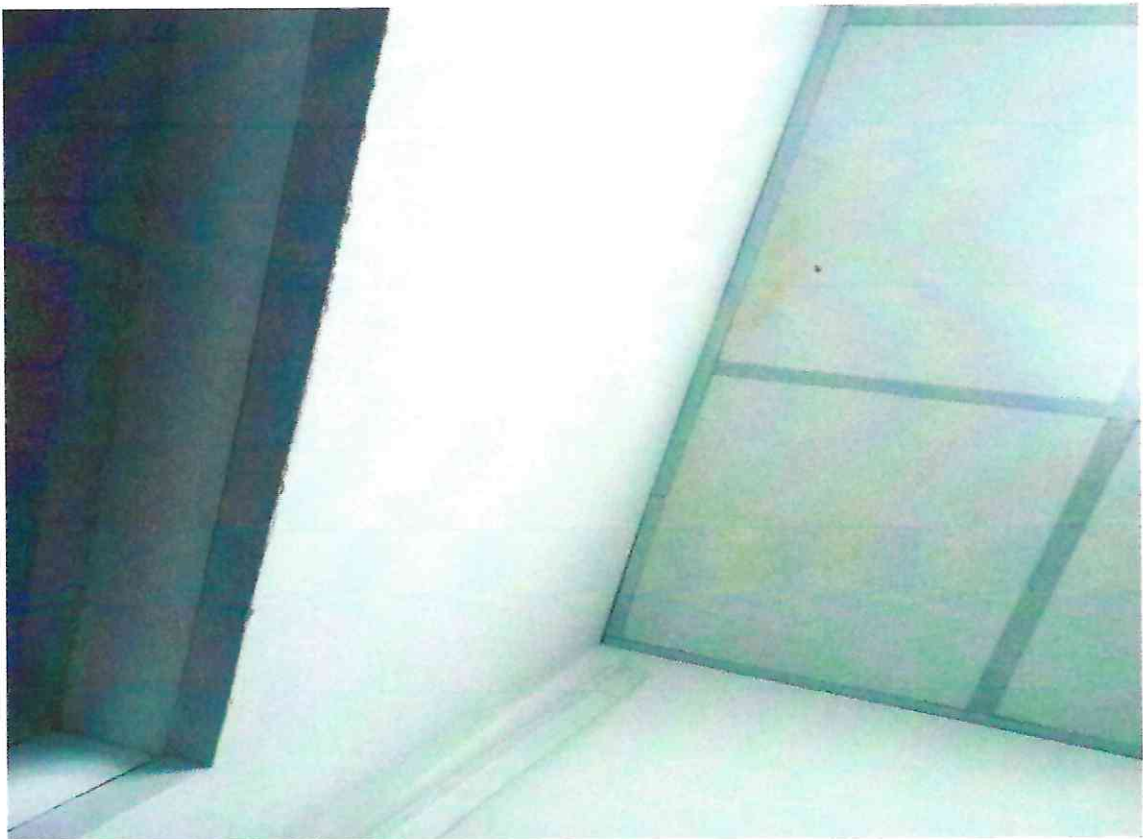
Фото № 36: Образование желтых пятен от протечки на потолке в административном помещении.
