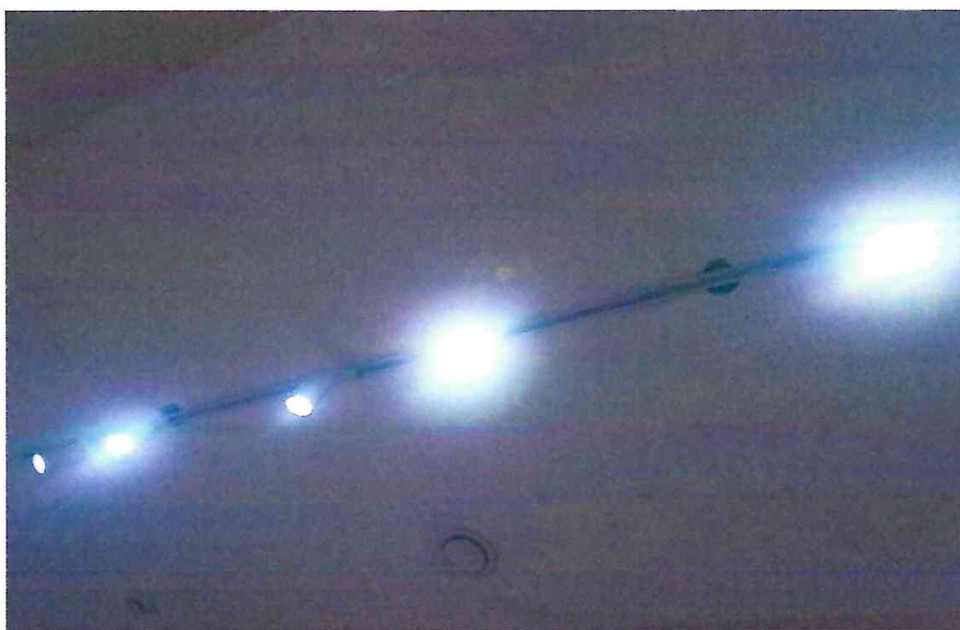
Фото № 46: Повреждения в виде отверстий в женской раздевальной с душевыми и туалетами.
