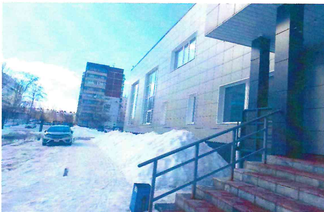
Фото № 2: Отвалы снега вдоль фасада здания.
