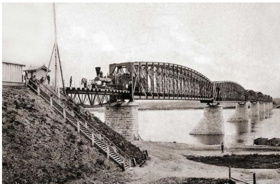
Железнодорожный мост через Обь
