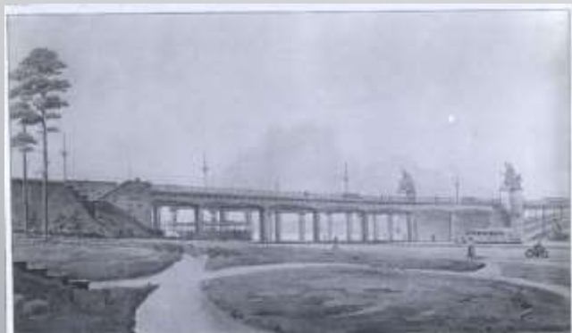
МОСТ через реку в Новосибирске Исторический снимок 1925 года Хранится в архиве ЦГА
